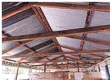
Foto 4: Entechado de la escuela.
